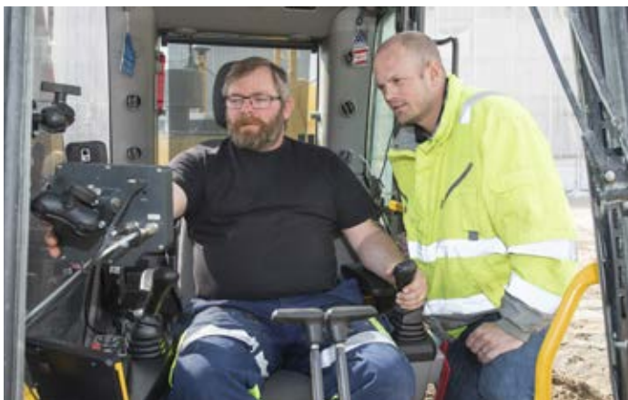
Grävmaskinist Mats Ornsäter visar Calle Andrés vilken stor nytta han har av det nya vågssystemet från STS för att exakt kunna kontrollera hur mycket han gräver och lastar i pågående projekt på Råsunda Fotbollsstadion.
