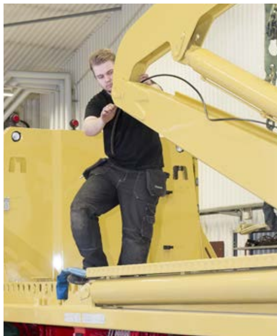
Servicetekniker Theodor Hedberg monterar här ett centralsmörjsystem på en containerlastbil till Wiklunds Åkeri.
